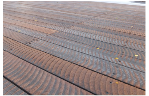
改修後の美しい連続した波模様 -裏面を再利用、波模様は滑り止めに-
