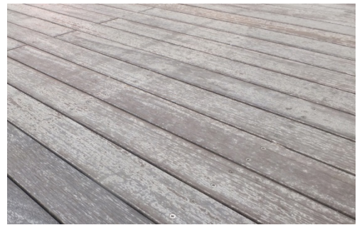
改修前のウッドデッキ -8年の年月を経て劣化-
