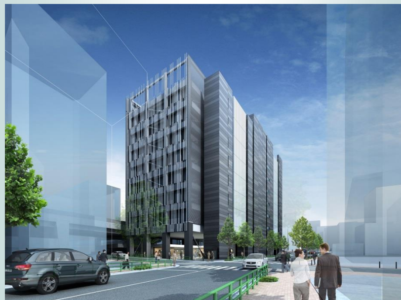
(仮称)銀座一丁目計画 【東京都中央区】 平成27年11月竣工予定
