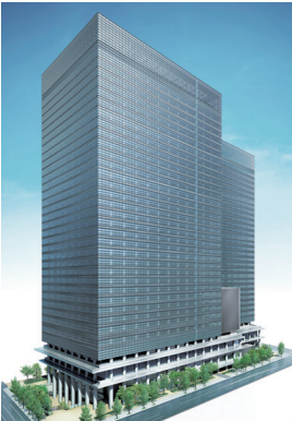
大手町二丁目地区第一種市街地再開発事業A棟
