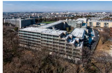
ウエリス仙川調布の森・ウエリスオリーブ成城学園前 全景
