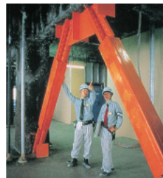
低降伏点鋼材を用いた 制震ブレース
