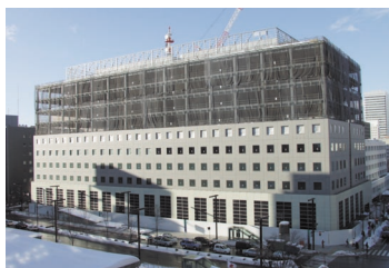
建設が進むアーバンネット札幌ビル（2004年2月）
