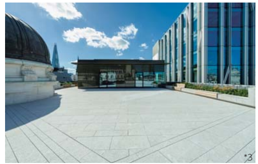
屋上テラス (増床部)
