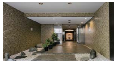
ウッドヴィル麻布共有部 エントランス改修前
