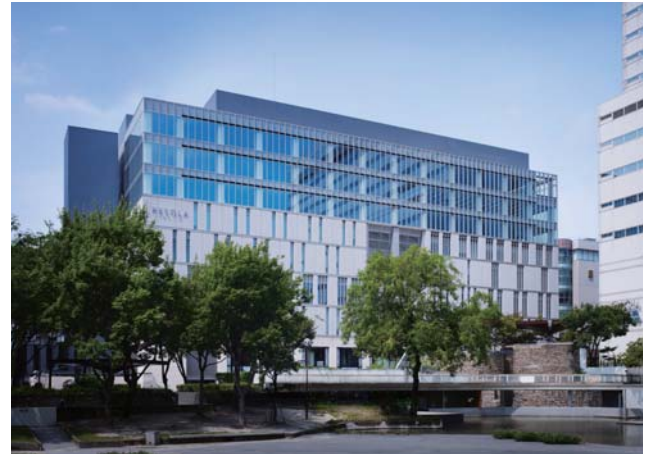
警固公園から望むアーバンネット天神ビル
