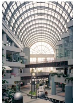
シーバンス「ア・モール」内観 撮影：門馬金昭写真事務所
