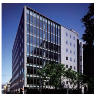
アーバンネット博多ビル (福岡市博多区)
