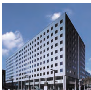
アーバンネット札幌ビル (札幌市中央区)
