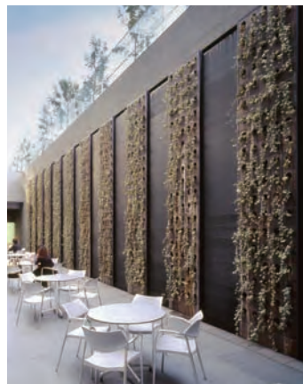
アーバンネット名古屋ビルのサンクンガーデン
