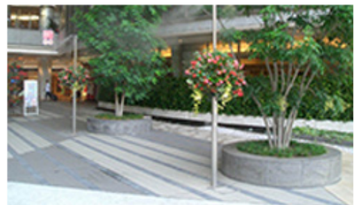
NTTクレド基町ビルのドライミスト
